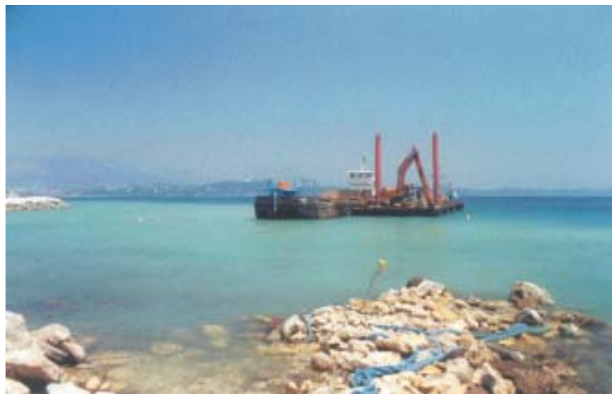
Fig. 72. Une barge et un engin de déroctage, lors du creusement d'un chenal d'accès à un port, dans le Var (France). On remarque la turbidité des eaux générée par les travaux. Photo P. Bonhomme.
