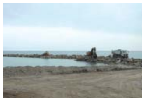
Fig. 64. Cervo (Province d'Imperia) : Réalisation d'un ouvrage de défense côtière (Archives Settore Ecosistema Costiero - Regione Liguria).
