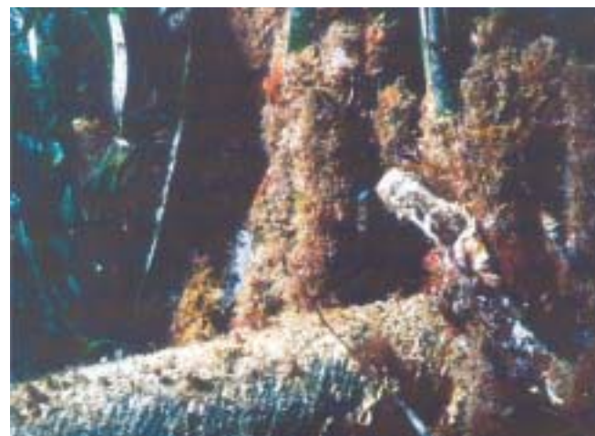
Fig. 118. Un câble mis en place en 1948, entre la Tour Fondue et Porquerolles (Var, France) est aujourd'hui recouvert par la "matte". La photo a été prise sur un tronçon où l'herbier à Posidonia oceanica est déchaussé, laissant apparaître le câble. D'après Charbonnel et al. (1995e). Photo E. Charbonnel.
