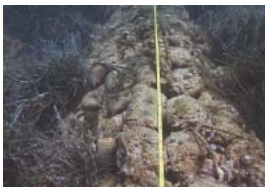
Fig. 114 Le câble électrique entre la Corse et la Sardaigne, près de Cala di Sciumara (Corse) a été mis en place en 1967. Sa fixation sur les herbiers superficiels (10-15 m) a été assurée par recouvrement sous de petits blocs de roche. 35 ans après, l'impact de ce recouvrement n'a pas évolué. Le trait qui traverse correspond au ruban gradué déroulé sur le fond lors des observations. D'après Pergent et al. (2002b).
