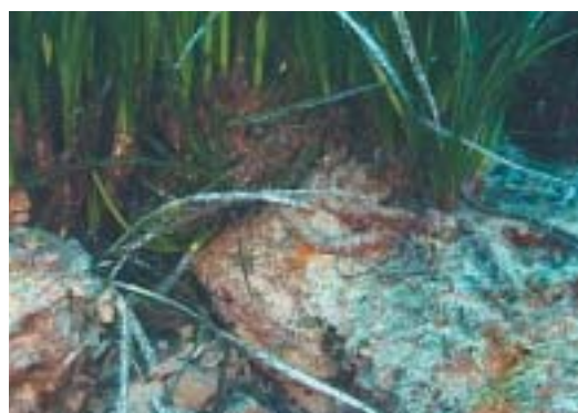
Fig. 115. Le câble électrique entre la Corse et la Sardaigne, près de Cala di Sciumara (Corse) a été mis en place en 1967. Sa fixation sur les herbiers s'est réduite par un début de recolonisation des blocs rocheux par Posidonia oceanica . D'après Pergent et al. (2002b).
