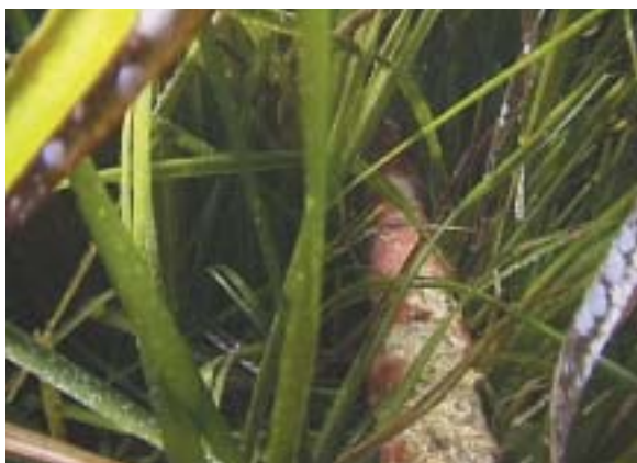
Fig. 113. Le câble électrique entre la Corse et la Sardaigne, simplement posé sur l'herbier près de Cala di Sciumara (Corse). 35 ans après sa mise en place (en 1967), il n'y a pas d'impact négatif sur l'herbier. D'après Pergent et al. (2002b).
