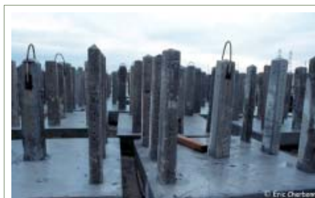
Fig. 89. Vue de modules de protection anti-chalut de type "Fakir" à base de poteaux électriques EDF (Electricité de France) reconditionnés. 91 modules de ce type ont été immergés en 1997 à l'intérieur et à l'extérieur de la Réserve du Cap-Couronne, dans le Parc Marin de la Côte Bleue. Photo E. Charbonnel.
