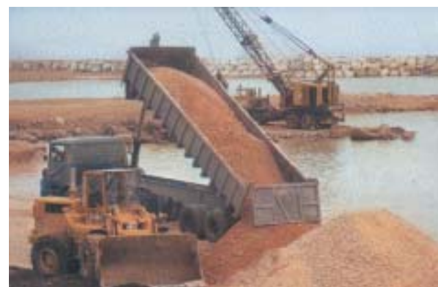
Fig. 58. Aménagement des plages artificielles du Mourillon (Toulon, Var, France). Camion déversant de la terre directement dans la mer.
